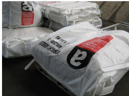
Asbestzement in Big Bags verpackt
