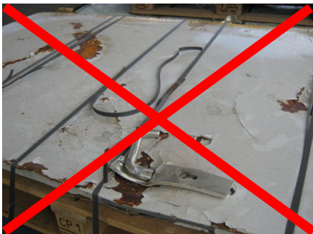
Falschanlieferung Brandschutztüren Beschläge und Griffe sind zu demontieren
