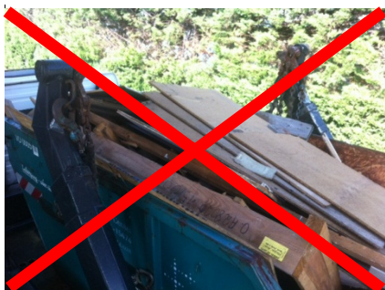
Überfüllte Mulden (Holzabfälle) gefährden die Transportsicherheit
